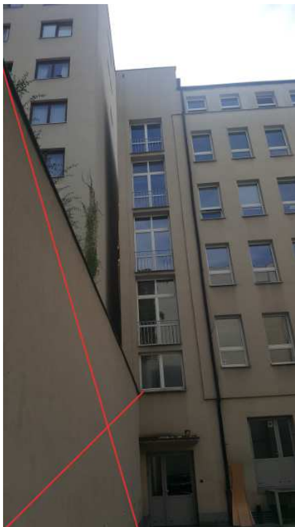
ZAZNACZONY MUR DO USUNIĘCIA
