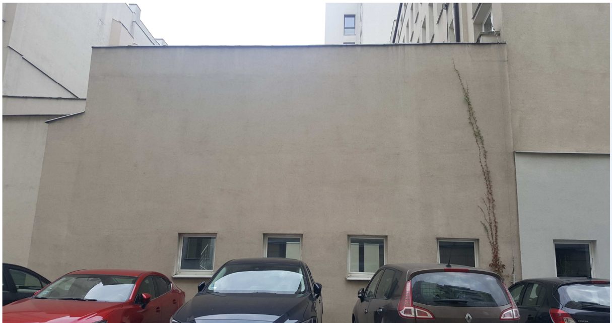
Fot. 4. Elewacja budynku od strony zachodniej
