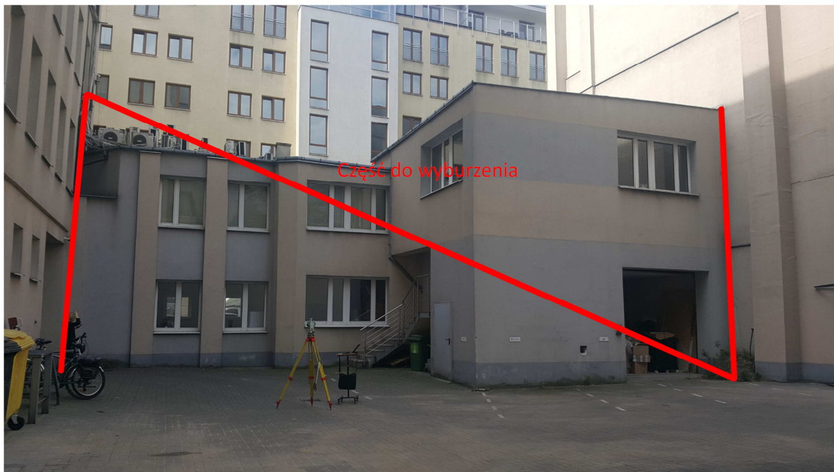
Fot. 1. Część budynku niskiego „a” do wyburzenia
