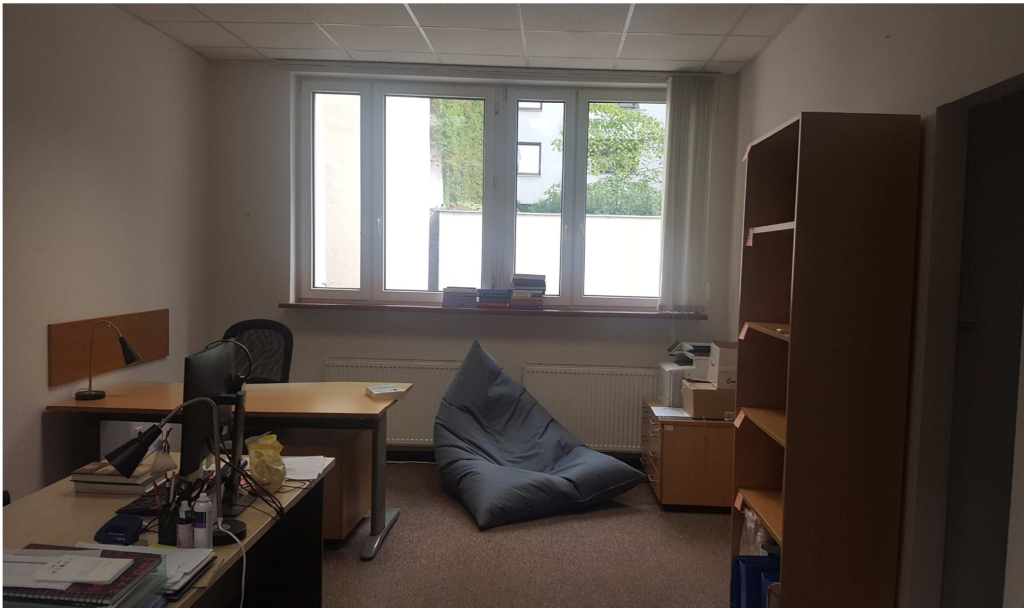
Fot. 13. Biuro na 1. piętrze w cz. niskiej - obudowa z płyt gk, sufit podwieszany
