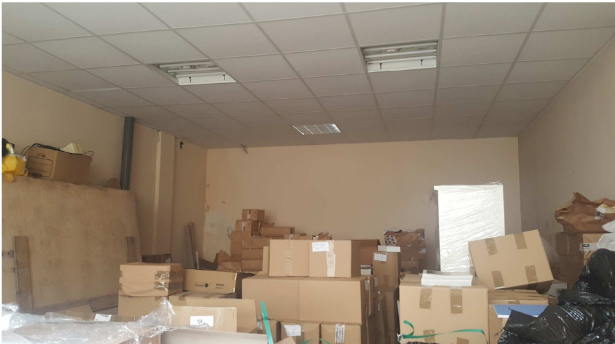
Fot. 11. Garaż na parterze - obudowa z płyt gk, sufit podwieszany
