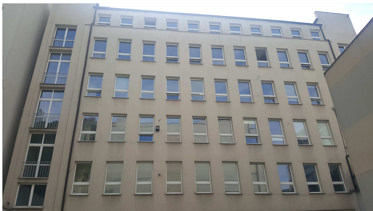
Fot. 6. Elewacja południowa budynku od strony dziedzińca
