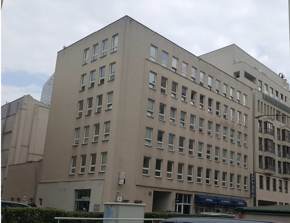
Fot. 2. Elewacja budynku od strony południowo - zachodniej
