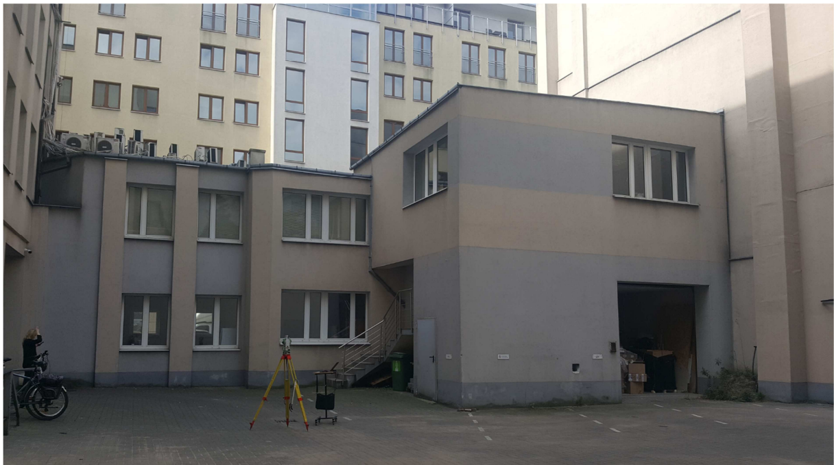
Fot. 7. Elewacja wschodnia budynku cz. niskiej od strony dziedzińca
