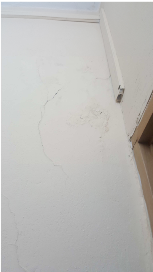
Fot. 14. Magazyn na 1. piętrze w cz. niskiej - rysa
