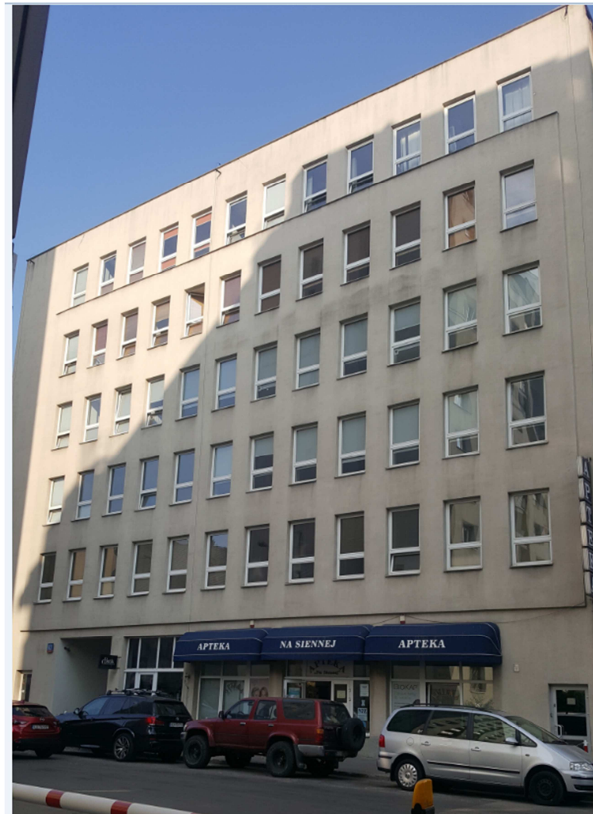
Fot. 3. Elewacja budynku od strony południowej
